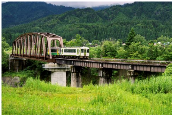
สะพานแม่น้ำทาดามิหมายเลข 7 (No. 7 Tadami River Bridge)
