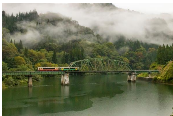
สะพานแม่น้ำทาดามิหมายเลข 5 (No. 5 Tadami River Bridge)
